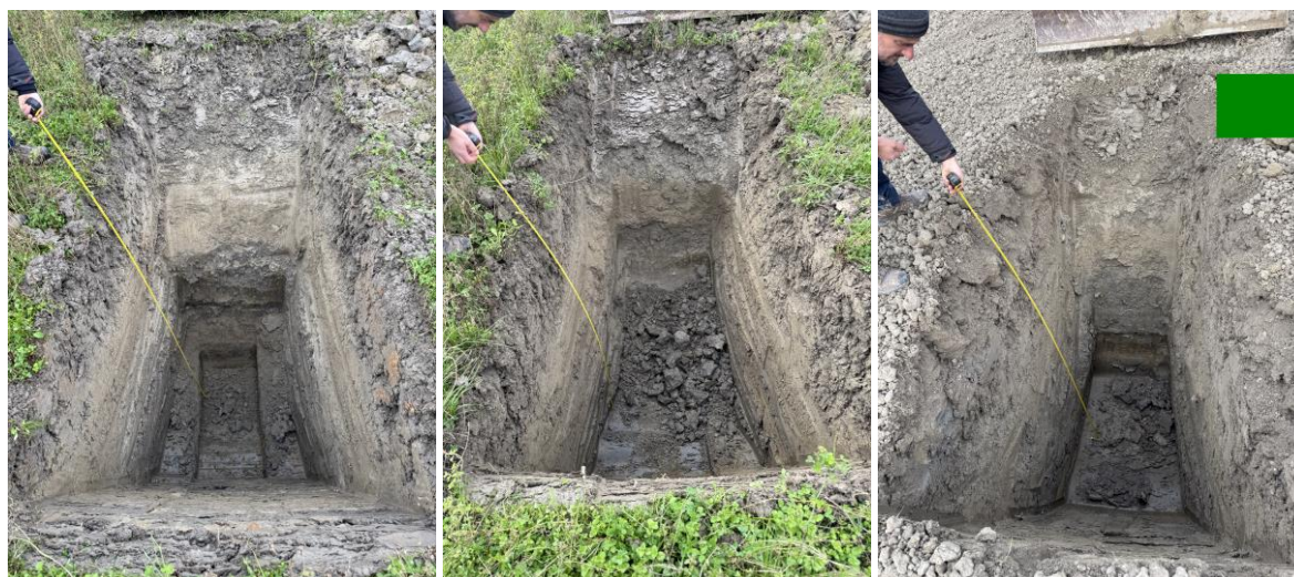
Figura 2.3: Esecuzione delle trincee esplorative in data 18/11/2024
